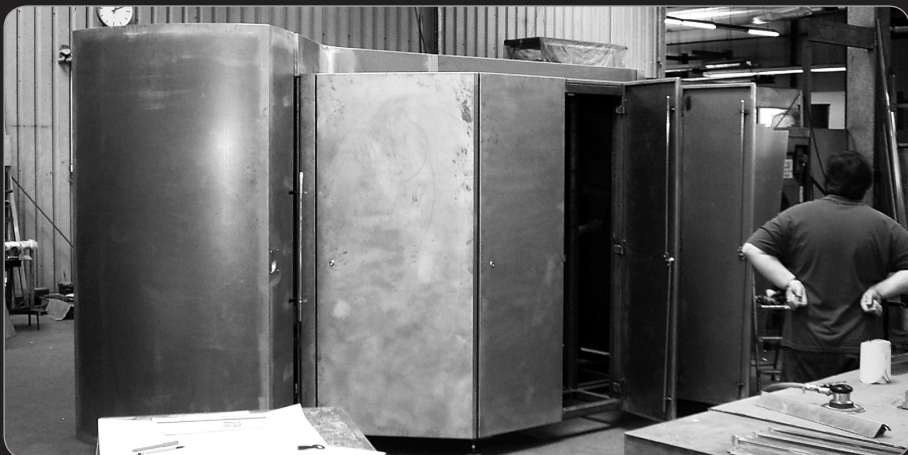
Abb.P_01: Fertigung der Blecheinhausung, Foto: M. Höllerich
