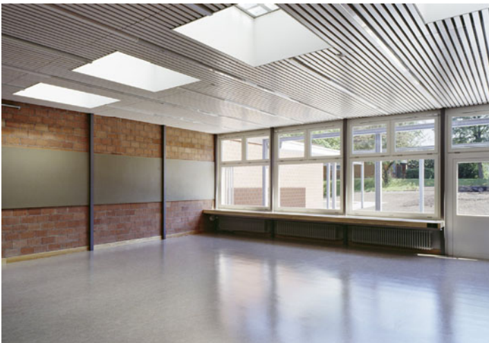
Bild 3-5 Oberlichtverkleidungen mit formaldehydgebundenen MDF-Platten der Emissionsklasse E1. Die Sonneneinstrahlung verursachte lokal hohe Temperaturen, was zu sehr starken Formaldehydemissionen führte.
