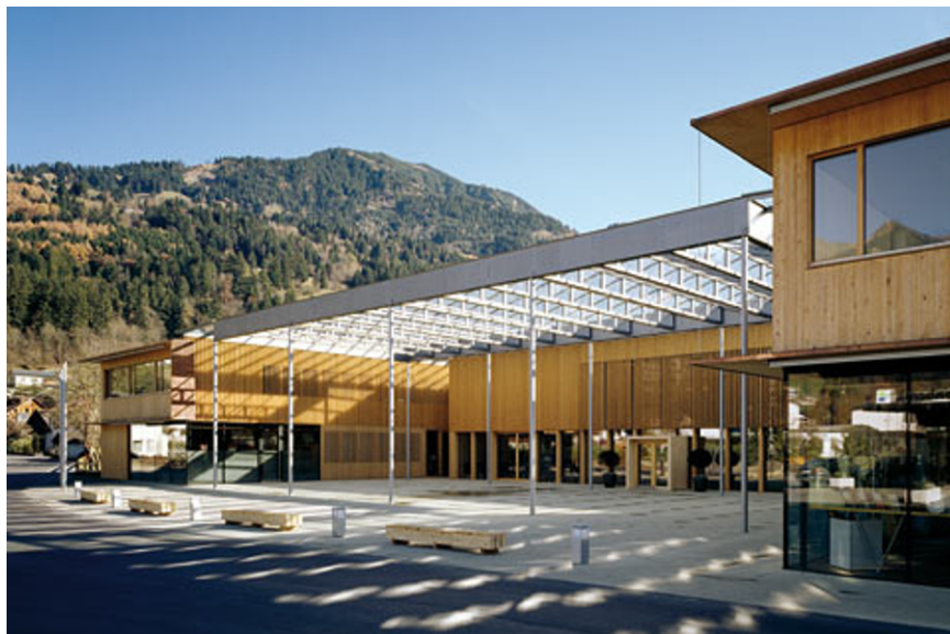
Bild 2-2 Gemeindeforum Ludesch, Vorarlberg. Das in Holzbauweise nach dem Passivhausstandard 2005 errichtete Gebäude vereint hohe Energieeffizienz, natürliche Baustoffe und nachgewiesenermaßen exzellente Werte für die Qualität der Innenraumluft und erbringt damit den Beweis, dass energiesparende Bauweisen und Wohngesundheits kein Widerspruch sind.
