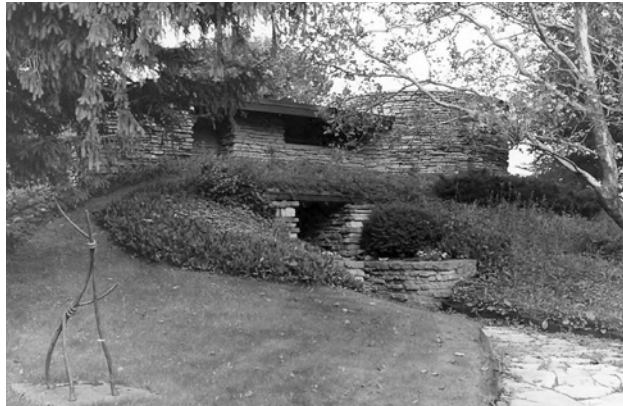
Abb. 5: Ansicht der geschlossenen und in den Erdhügel eingelassenen Nordseite des Solar Hemicycle House (Quelle: Thomas Yanul)
