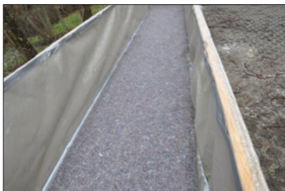
Abb. 1: Ausgelegtes Nadelflies auf dem Boden des Behälters, Foto Fa. Otto Richter Feuchteklinik GmbH
