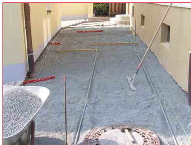
Abb. 3.7 – Für größere gepflasterte Flächen kann die Betung für das Pflaster in mehrere Bahnen eingeteilt werden, in die Rohre als Führungsschienen waagrecht verlegt werden, damit das Splittbett optimal gerade wird. (Foto: RUF Baustoffwerk)
