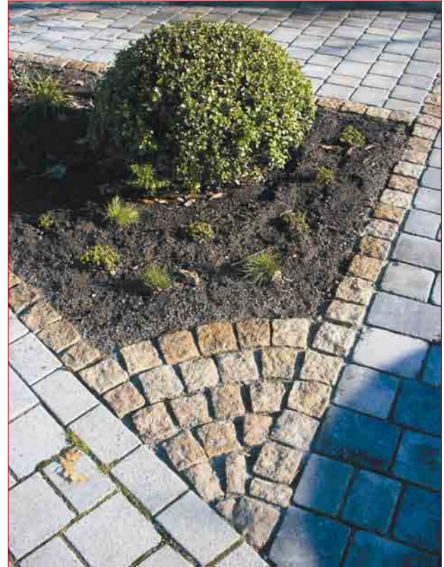
Abb. 3.9 – Natursteine werden oft auch mit Betonpflastersteinen kombiniert. (Foto RUF Baustoffwerk, Schnelldorf)
