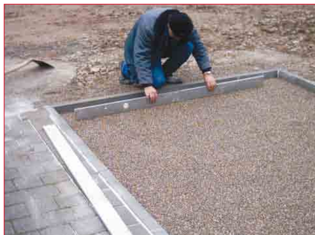
Abb. 3.6 – Für die Kontrolle oder Nachbesserung der Glättung von größeren Splittflächen ist eine ca. 2 m lange Wasserwaage erforderlich. (Foto: RUF Baustoffwerk, Schnelldorf)
