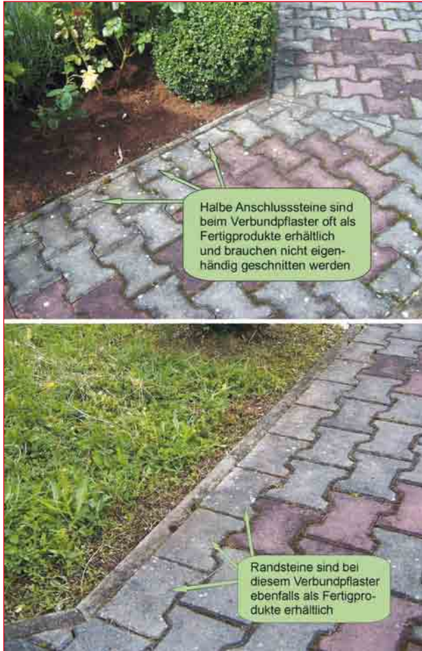
Abb. 3.12 – Bei einigen Verbundpflastern sind auch Anschlusssteine (Randsteine) erhältlich.
