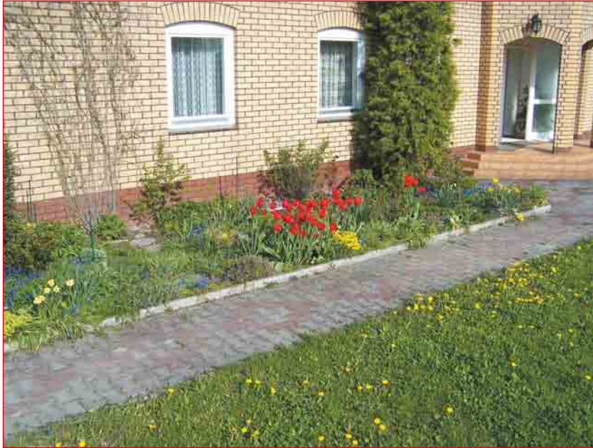
Abb. 3.1 – Gerader Gartenweg mit zweifarbigen Betonverbundsteinen
