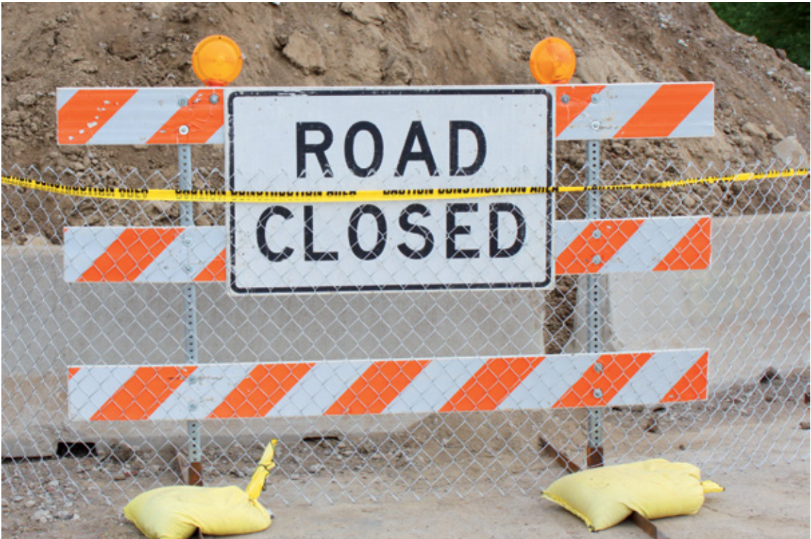
So sehen Aufbaulichter und Barken auf einer echten Baustelle aus.
