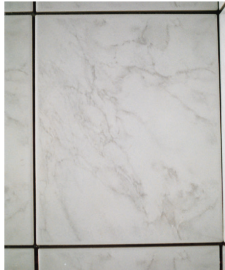
Abb. 1.26: Ungleichmäßiges Fugenbild
