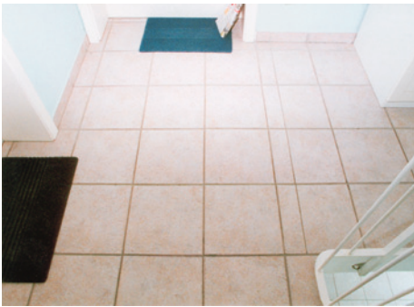
Abb. 1.20: Überflüssige Fuge in der Bodenverfliegung. Der Bodenbelag wurde von 2 Seiten aus verlegt. In der Mitte entstand eine Lücke, die größer war als die Fliesenbreite.
