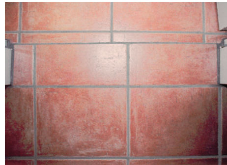
Abb. 1.17: Der Seitenversatz des Fugenrasters im Türrdurchgang stellt eine optische Beanstandung dar.
