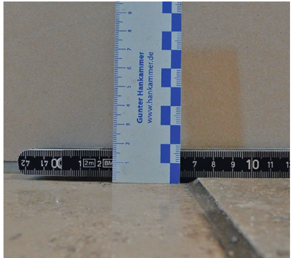
Abb. 1.12: Überzähne als Höhenversprung
