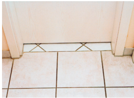
Abb. 1.21: Trennfuge des Belagwechsels liegt nicht unterhalb des Türblatts (optischer Mangel)
