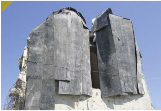
Abb. 1.18: Anbringung einer Abdeckung aus Gummimatten gegen Splitterwirkung (Quelle: Richard Liesegang GmbH & Co. KG, Hürth)
