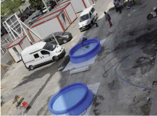
Abb. 1.12: Einsatz von Plastik-Planschbecken zur Staubbinderung (Quelle: W. Werner, Stolberg)
