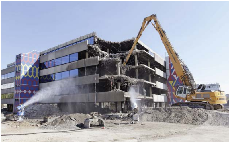
Abb. 1.11: Einsatz von Staubbindemaschinen (Quelle: Eten-gruber GmbH Abbruch und Tiefbau, Dachau)
