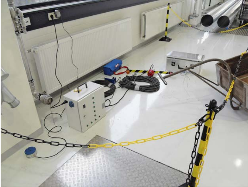
Abb. 1.30: Aufstellen eines Erschütterungsmessgerätes mit Warnsignaleinrichtung (Quelle: Richard Liesegang GmbH & Co. KG, Hürth)
