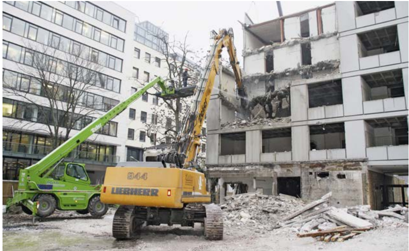
Abb. 1.9: Einsatz von C-Schläuchen zur Staubbekämpfung (Quelle: Robert Zeller GmbH & Co. KG, Offenbach)
