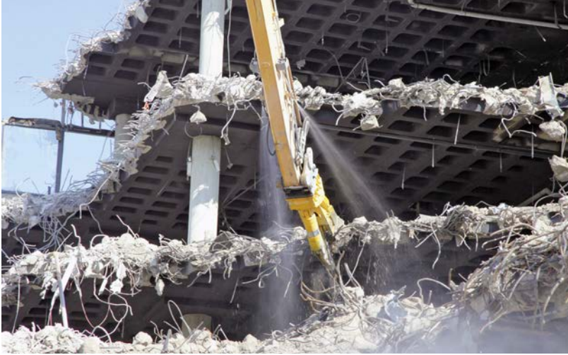
Abb. 1.10: Wasser-sprüheinrichtung am Ausleger (Quelle: Eten-gruber GmbH Abbruch und Tiefbau, Dachau)
