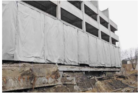
Abb. 1.19: Abdeckung von Auswurfbereichen mit Vliesplanen (Quelle: Richard Liesegang GmbH & Co. KG, Hürth)
