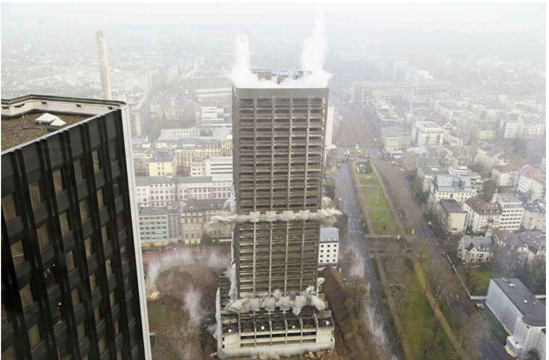
Abb. 1.13: Sprengung des AfE-Hochhauses mit den auf dem Dach gezündeten Wasserkanistern (Quelle: M. Schröder, Erfstadt)
