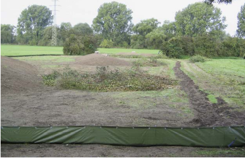
Abb. 1.31: Schaffung einer Ersatzfläche für Eidechsen im Zuge einer Abbruchmaßnahme (Quelle: Dr. Hug Geoconsult GmbH, Oberursel)
