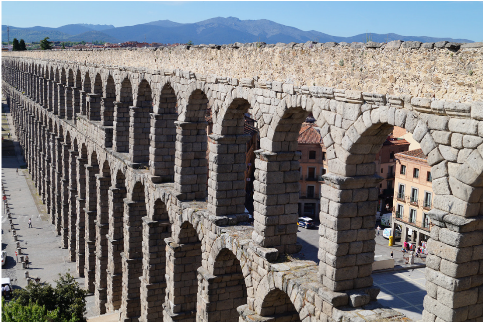
Bild 1.2 Aquädukt von Segovia in Spanien
