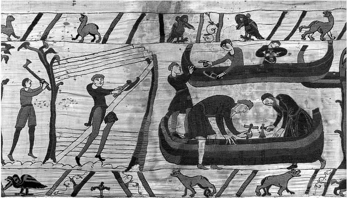
Wandteppich von Bayeux, spätes 11. Jh.: Bau der normannischen Flotte
